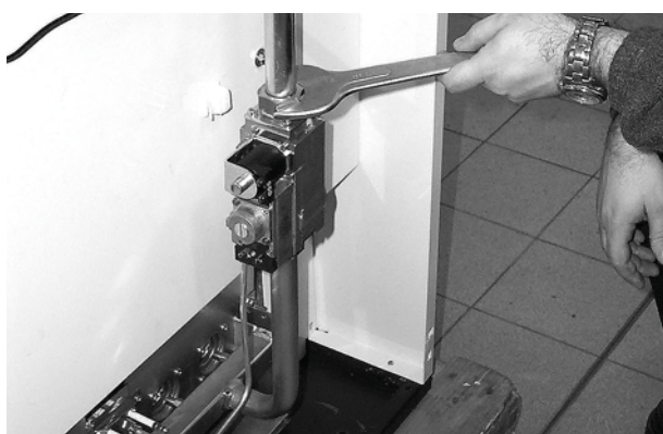
рис. 9 - Открутите гайку трубы подачи газа
